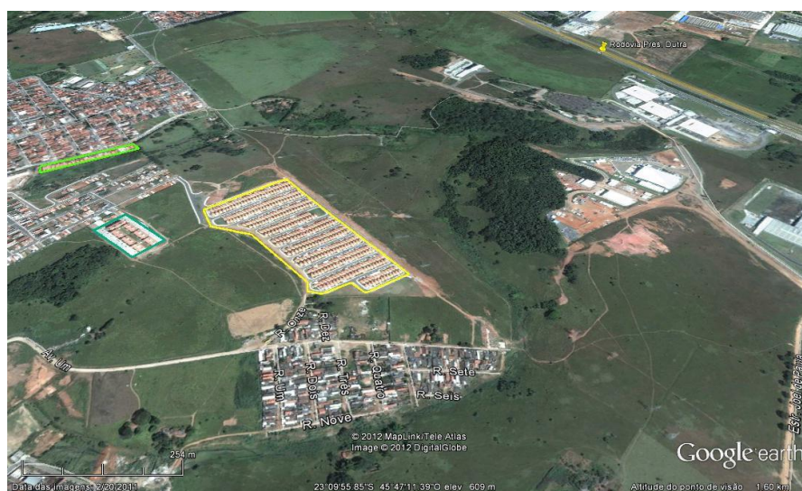
Figura 10: Residencial Frei Galvão. Região Leste.
